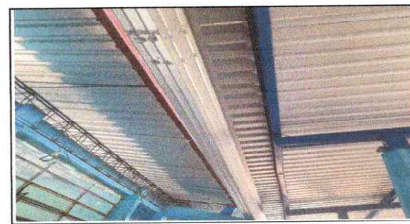
foto 5: Sustitución de canal de metal AULAS 8,9 Y PATIO
