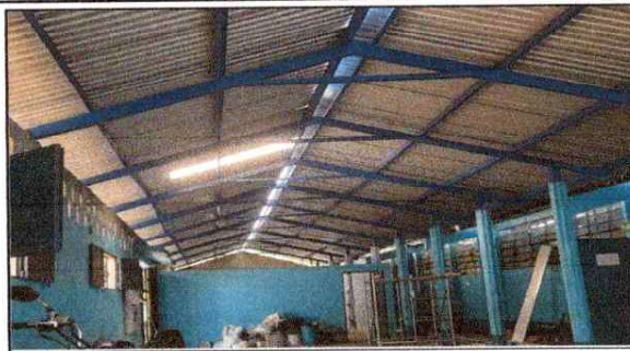
foto 2: Mantenimiento a estructura de soporte de metal. AULAS 8,9 Y PATIO
