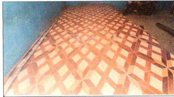
foto 4: Sustitución de cemento liquido (por piso ceramico) AULAS 8,9 Y PATIO
