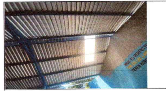
foto 6: Sustitución de lámina, por lámina troquelada aluzinc calibre 26 AULAS 8,9 Y PATIO
