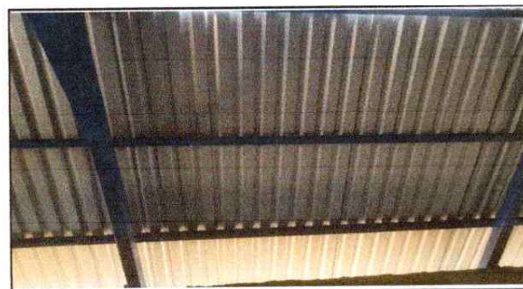
foto 3: Sustitución de estructura de soporte de metal, por metal. AULAS 8,9 Y PATIO
